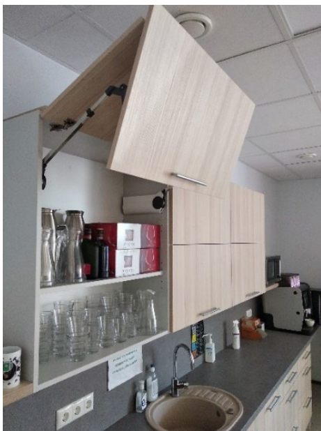
Joonis 9.4 Köögimööbli ülemiste kappiuste lahendused (vasakul kõrgem kapp kaheosalise uksega, paremal madalam kapp üheosalise uksega).
