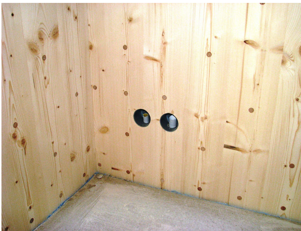
Joonis 5.28 Tüüblitega ühendatud ristkihtliimpuit. Foto: M. Riistop
