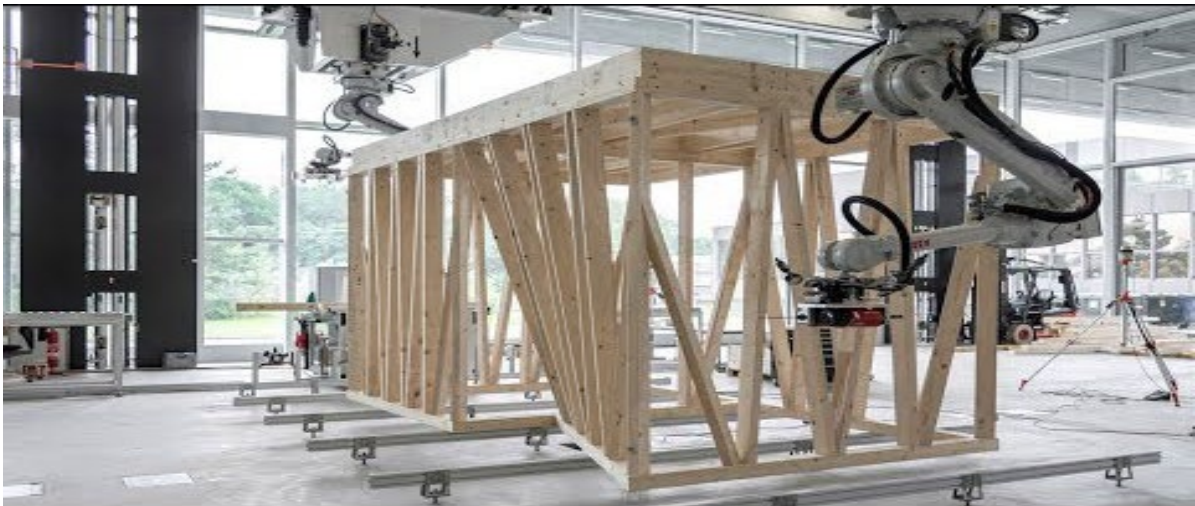
Joonis 10.62 Puitkonstruktsioonide ehitamine robotitega ETH Zürich.
