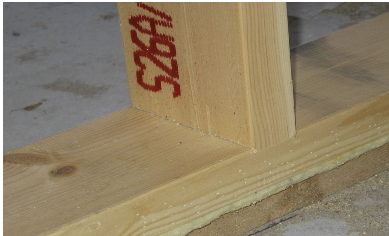
Joonis 4.16 Karkassipostide T- seotis. Foto: M. Riistop
